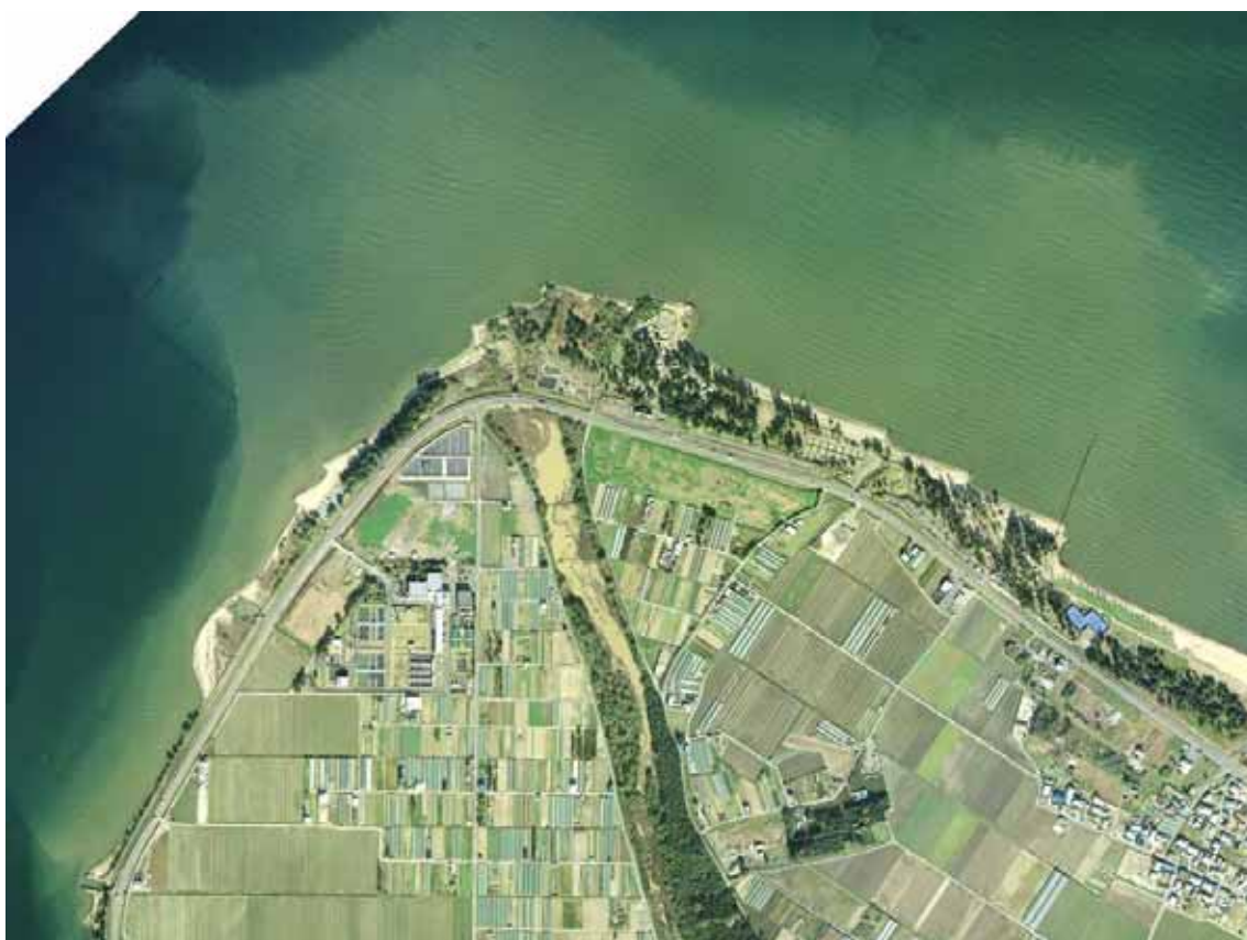
図 22 調査場所の空中写真 「国土交通省近畿地方整備局琵琶湖河川事務所提供」
