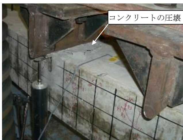
写真-6.4 供試体上縁における圧壊状況
