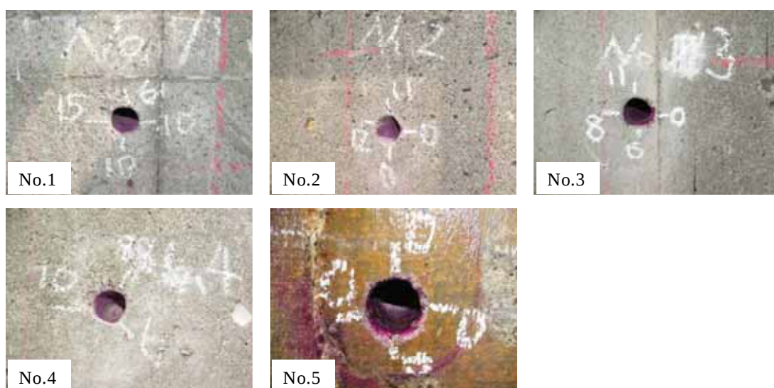
写真-3.6 中性化深さ測定状況
