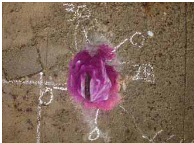
写真-3.4 中性化試験（フェノールフタレイン法）状況例
