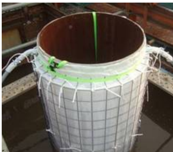
図－4.3 型枠ユニット設置完了
