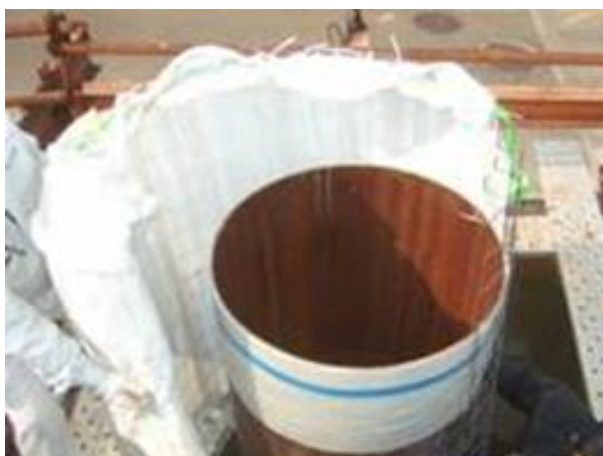
図－4.2 型枠ユニットの設置状況（鋼管上部にはエポキシ樹脂塗布済）
