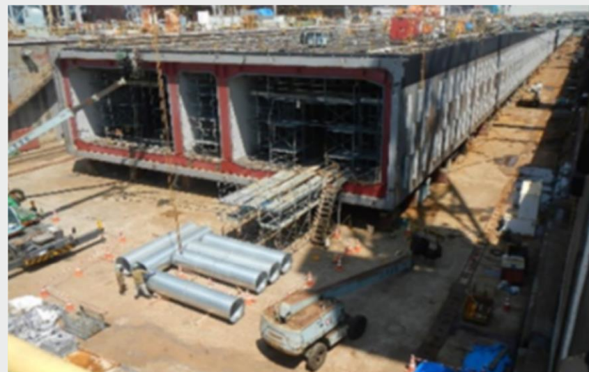
東京港臨港道路 南北線沈埋函製作
