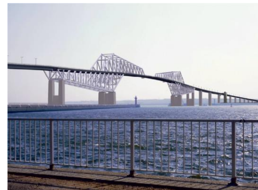
東京ゲートブリッジ
