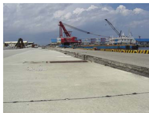
岸壁(-5.5m)〔直立消波式〕
