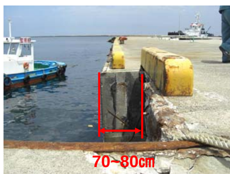
岸壁(-5.5m)〔直立消波式〕
