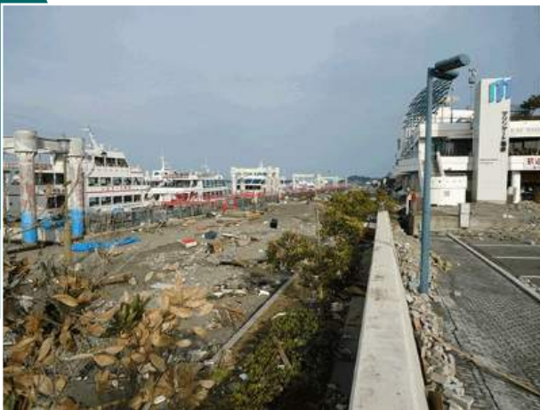
西埠頭(マリンゲート塩釜前)被災状況
