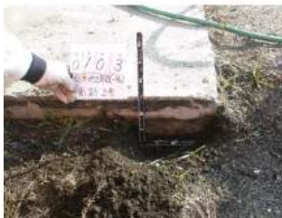
写真 1c) エプロン部の沈下
