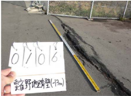
写真-2c) 沈下、アスファルトの亀裂
