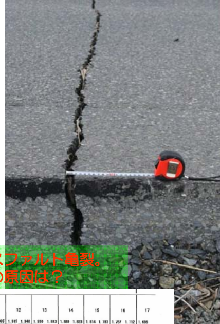
数カ所エプロンを横断貫通する舗装クラック。 (幅1cm以上)
