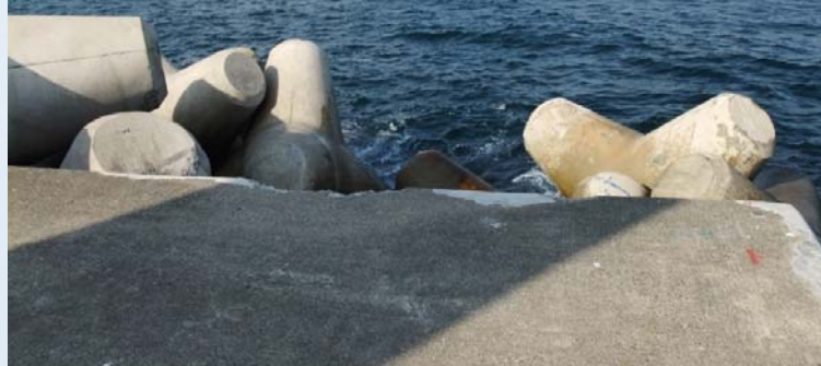
久慈港 防波堤堤頭部周辺の 消波ブロックの飛散・沈下
