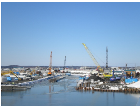
航路護岸本体工の冬期間での施工監理
