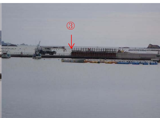
③既設岸壁嵩上げ
