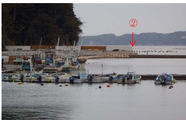
②既設護岸嵩上げ
