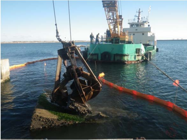
⑤コンクリート殻撤去
