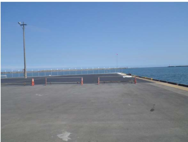
⑬工事完了
