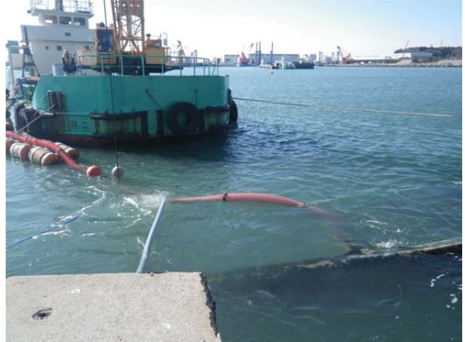
⑥サンドポンプによる中詰砂撤去
