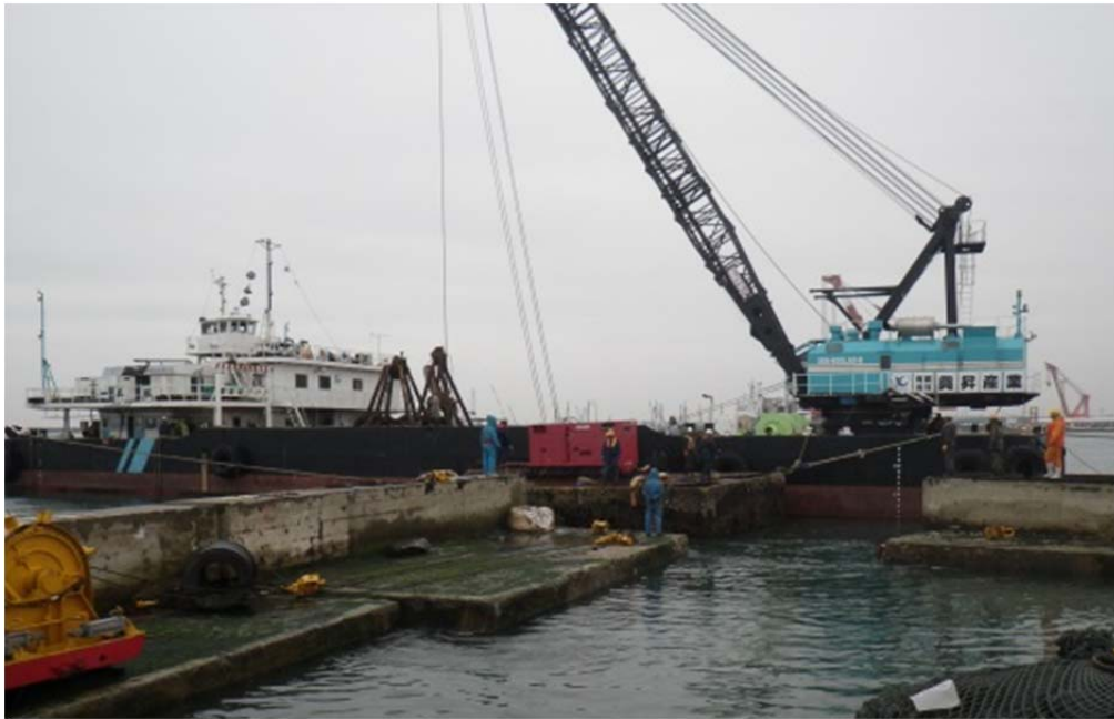
⑩ケーソン据付
