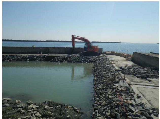
⑫裏込石投入
