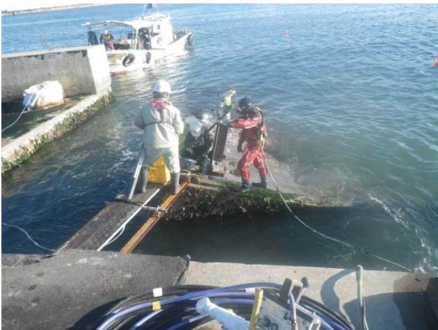
③蓋コン端部コア抜き
