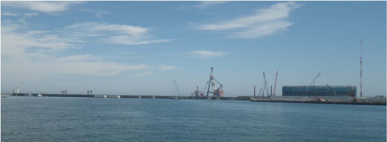
⑮第 5 埠頭東京ガス LNG 基地
