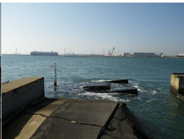
②埋没したケーソン
