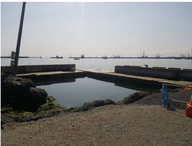
⑪蓋コン打設完了
