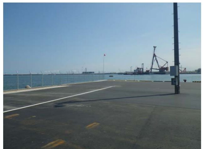
⑭工事完了
