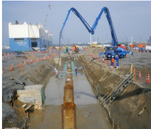
・ ガントリークレーン基礎杭部
