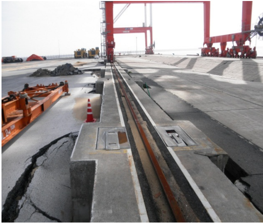
・ ガントリークレーンの岸壁・基礎被災
