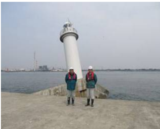
仙台港C防波堤堤頭部被災状況
