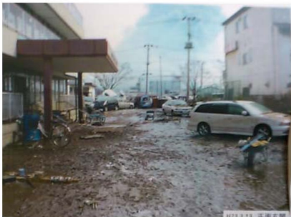
塩釜港湾空港事務所被災状況 2
