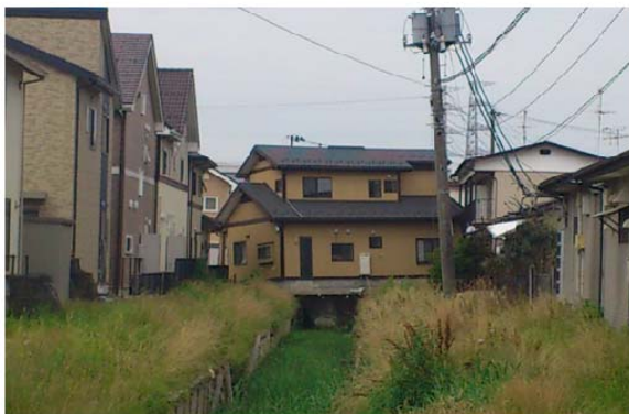
水路上に漂流して手付かずの家屋(多賀城市)
