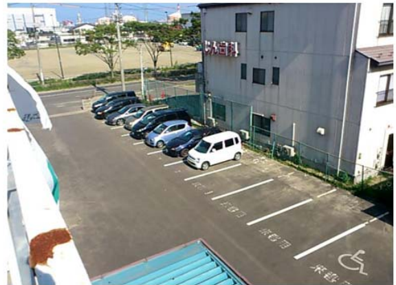
塩釜港湾空港事務所復旧状況 1
