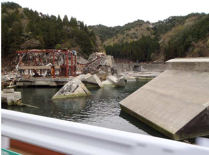
防潮堤が完全に倒壊
