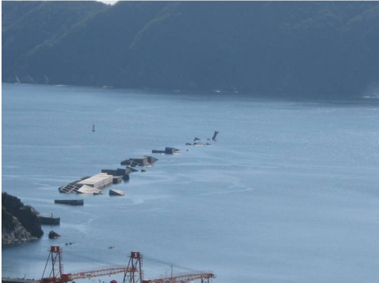
防潮堤が完全に倒壊
