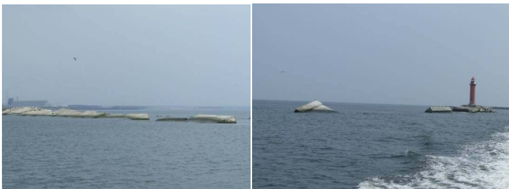
八太郎地区北防波堤（ハネ部・中央部）の被災状況
