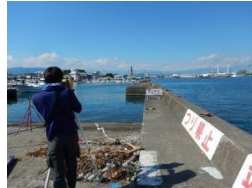
①標定点（レーザリフレクタ）の設置・観測
