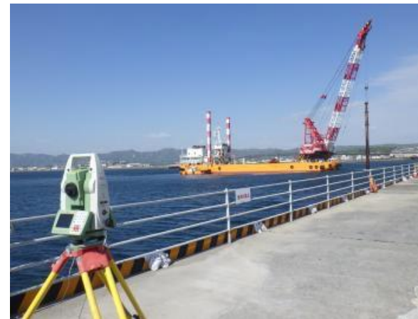
TSによる計測状況
