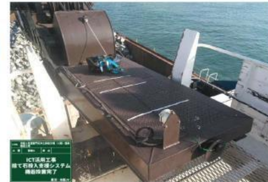
計測装置取付完了
