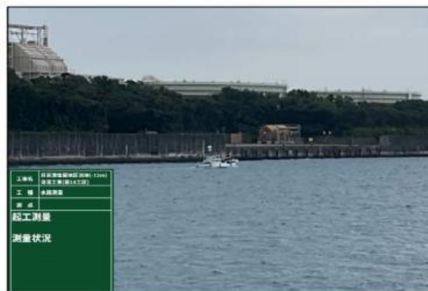
起工測量状況
