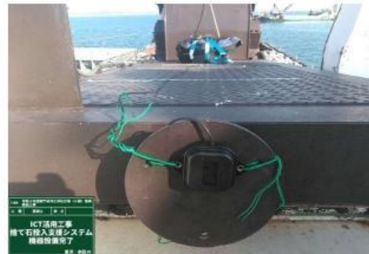
GNSS外部アンテナの固定
