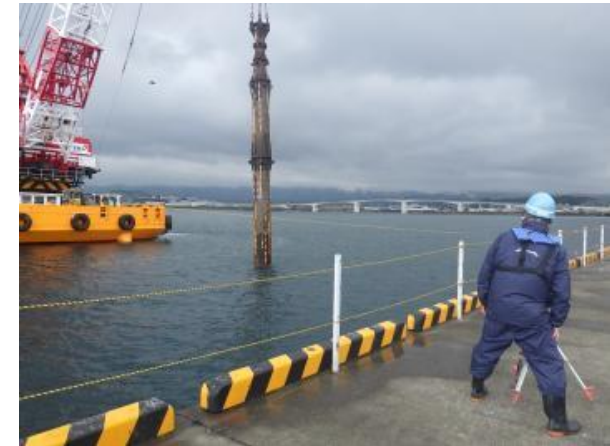
レベルによる高さ計測状況
