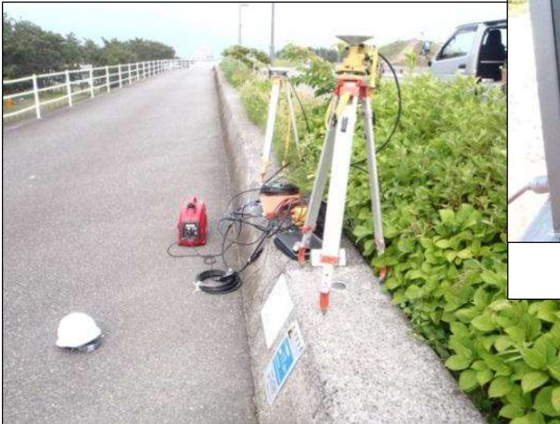
GNSS設置状況
