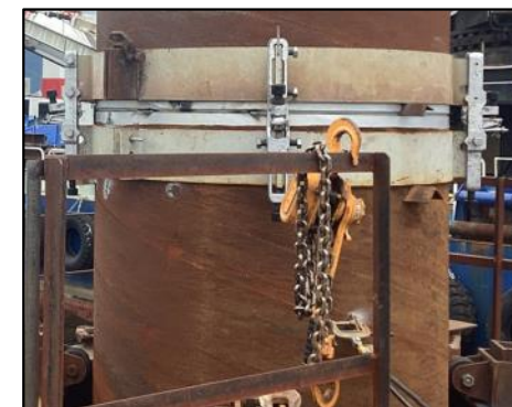
「建て方エース」実施状況
