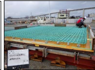
リプレイサブル床版製作状況
