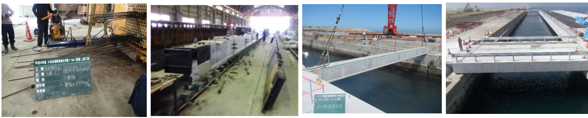
CFRP材の緊張作業 型枠脱枠 部材の架設 架橋完了
