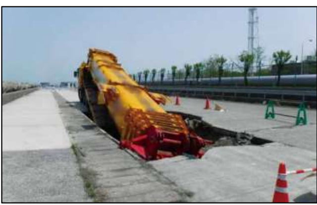
埋立護岸による陥没の発生状況
