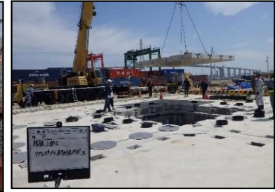
床版の設置状況
