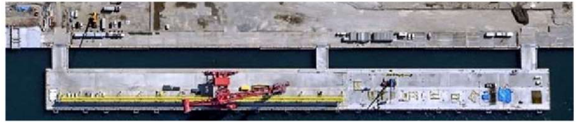
小名浜港(東港地区)岸壁18m(耐震)
