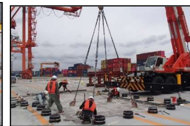
施工性確認試験実施状況(左:床版撤去、右:床版再設置(据付))
