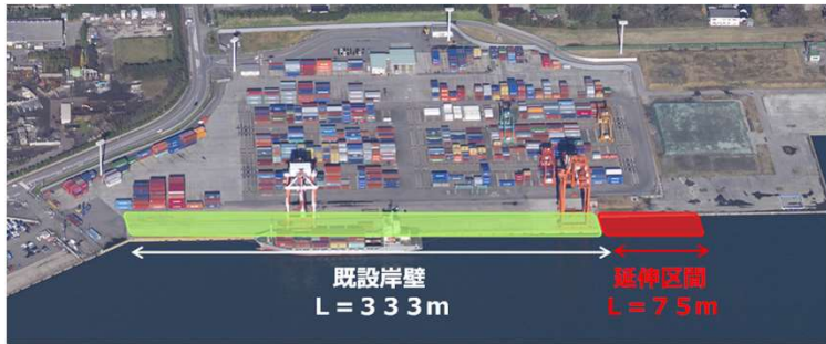
伏木富山港(新湊地区)岸壁12m
