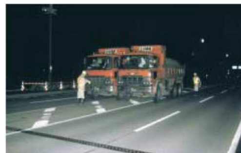
写真2 主桁載荷試験状況
