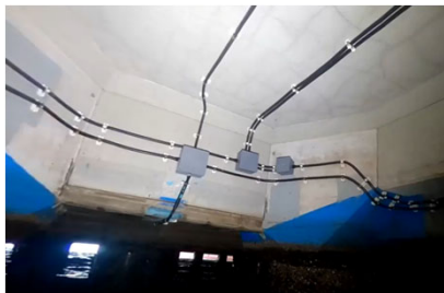
写真2 面状陽極設置写真
