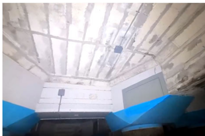
写真1 線状陽極設置写真
