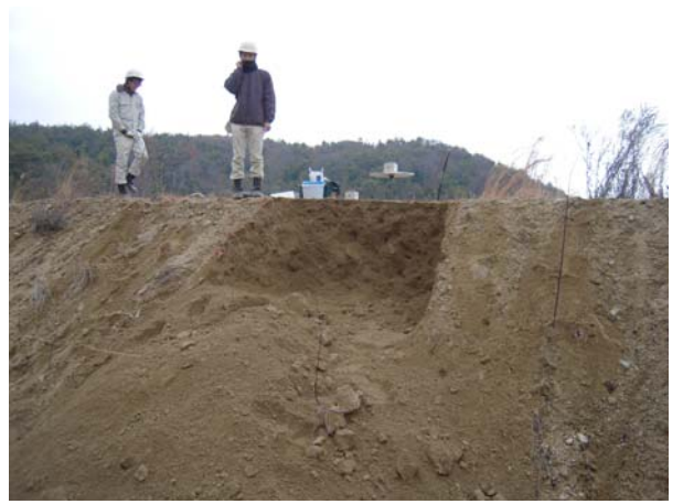
写真 7-3 掘削後の盛土の様子
