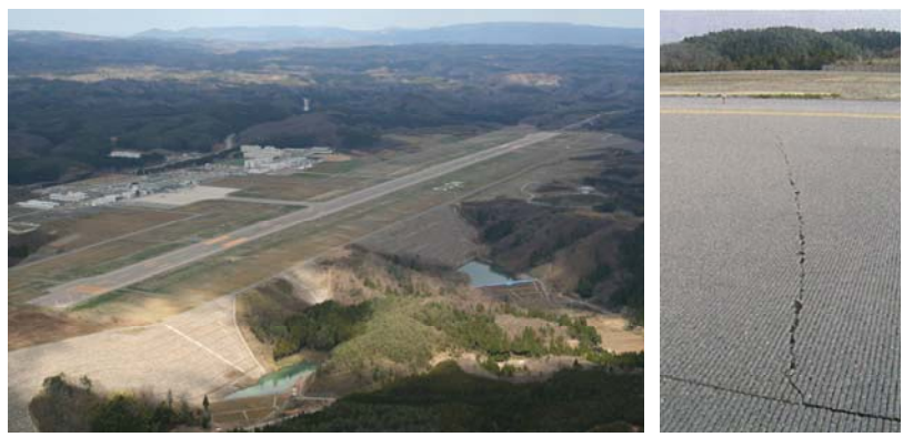
写真 5-2 対象フィールドとなる能登空港と滑走路クラック発生状況 12)
